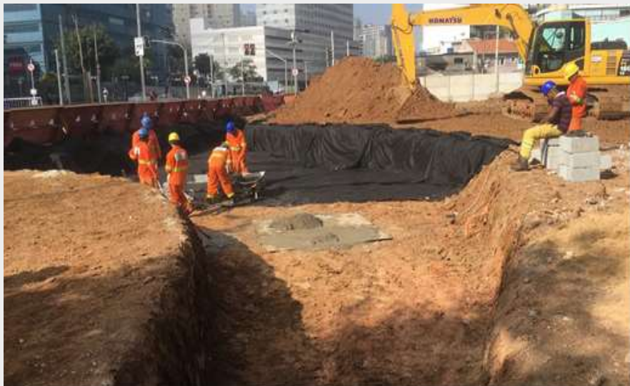
ABERTURA DE CAIXAS PARA EXECUÇÃO DOS JARDINS DRENANTE
