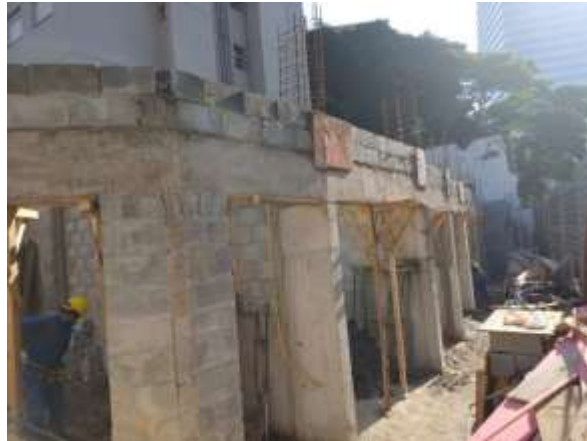
Execução da alvenaria
