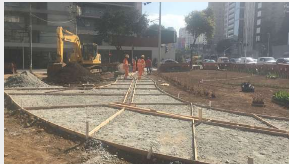
EXECUÇÃO DE FORMAS DE MADEIRA PARA CONCRETAGEM DOS PASSEIOS
