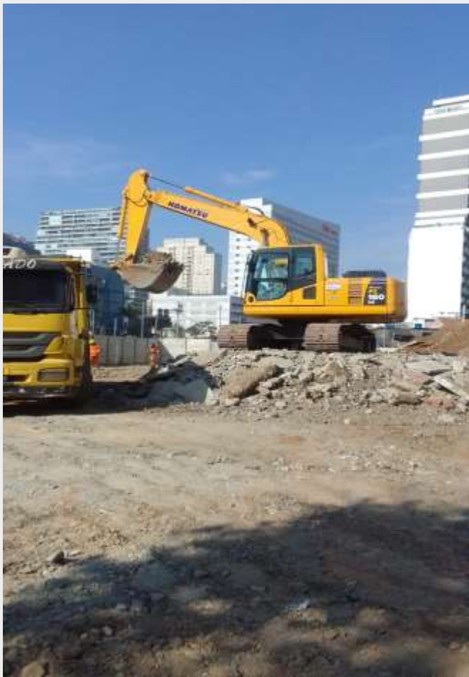
DEMOLIÇÃO DOS IMÓVEIS EXISTENTES NO LOCAL ONDE SERÁ CONSTRUÍDA A PRAÇA
